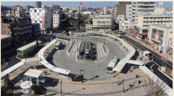
再開発後の国分寺駅北口広場
